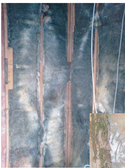
上の画像は内部結露により菌が発生し築十数年にも関わらず断熱の機能を失っている断熱材です。
