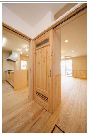
図3 洗面室扉の上部開口
